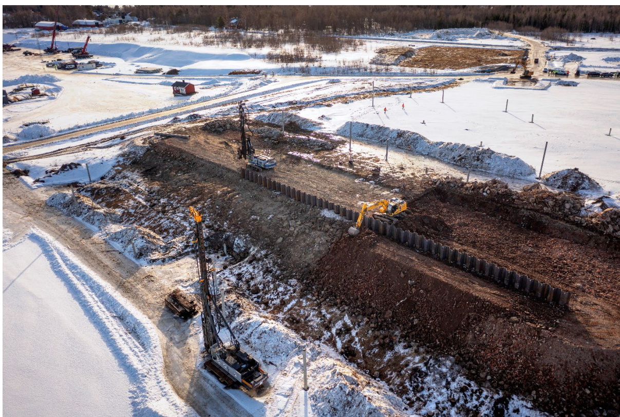
Översikt över pågående markanläggningsarbeten inför byggnation av Cinis Fertilizers produktionsanläggning i Köpmanholmen.
