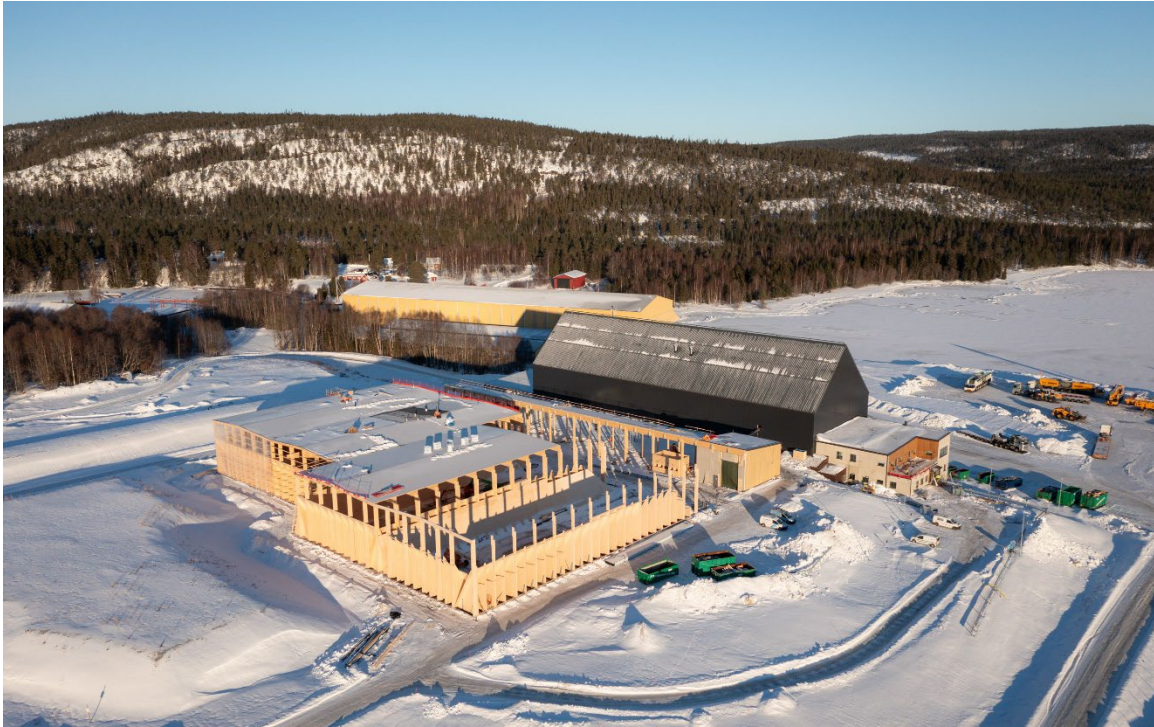
Processanläggning och saltlager i slutet av januari 2024. Sista delen av taket till saltlagret monterades i början av februari och i leveranserna till lagret inleddes i slutet av månaden. Foton: Leif Wikberg och Pirkko Westin
